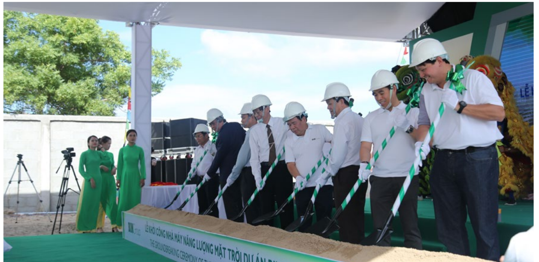
Ngày 23/1/2018, tại thôn Quán Thê, Ninh Thuận, BIM Energy cùng đối tác là AC Energy - Công ty thành viên mảng Năng lượng thuộc Tập đoàn Ayala (Philippines) long trọng tổ chức Lễ Khởi công Dự án Nhà máy điện mặt trời dự án BIM 1 (Dự án 18E).
